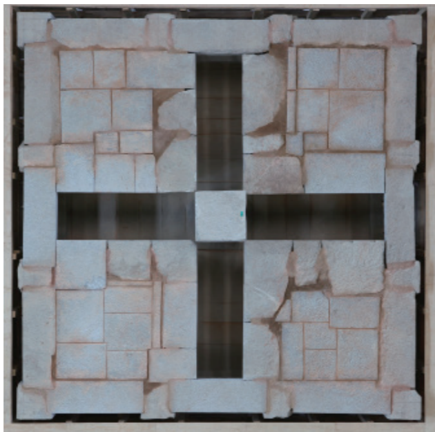
미륵사지 석탑 안쪽의 십자형 통로
