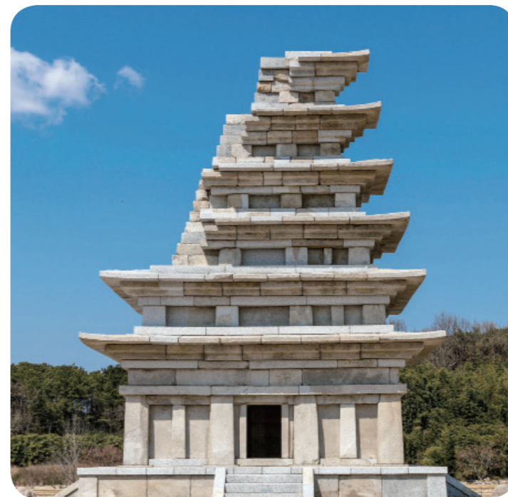
해체 · 보수 후 미륵사지 석탑
