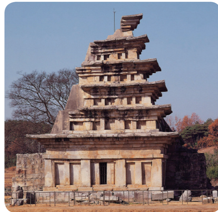
해체 · 보수 전 미륵사지 석탑
